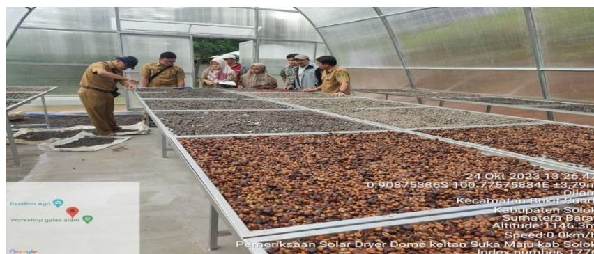
Gambar 41. Bangunan solar dryer dome di kelompok tani sukamaju nagari Sirukam kec. Payung Sekaki
