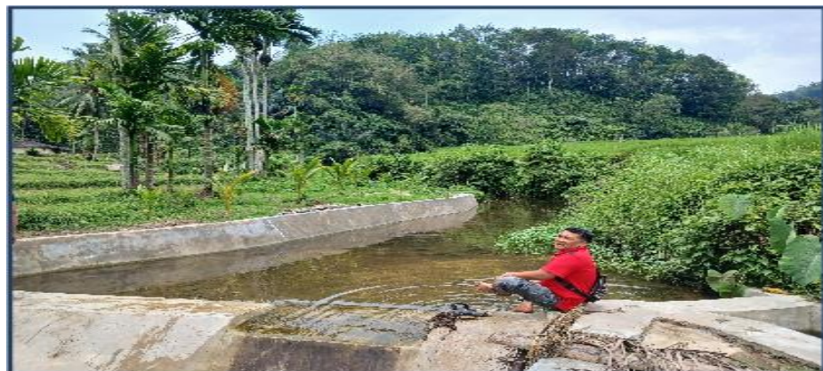
Gambar 5. Kegiatan pembangunan dam parit di Nagari Indudur Kec. IX Koto Sungai Iasi
