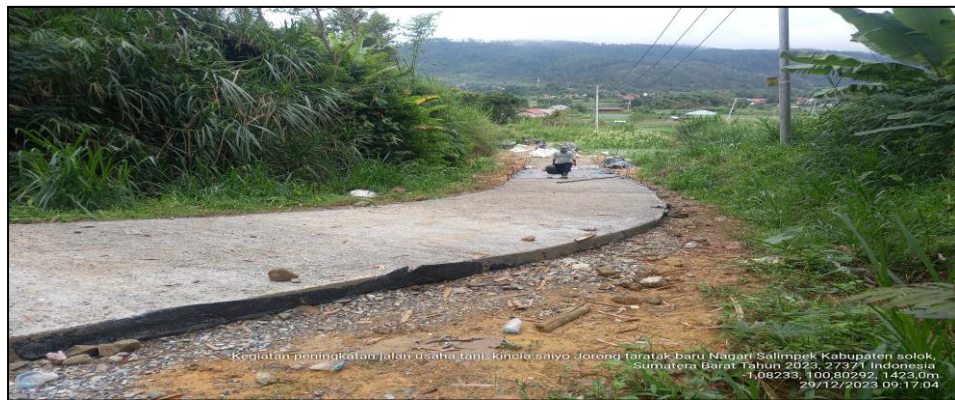
Gambar 26. Pembangunan jalan usaha tani di kelompok tani kincia saiyo kec. Lembah Gumanti
