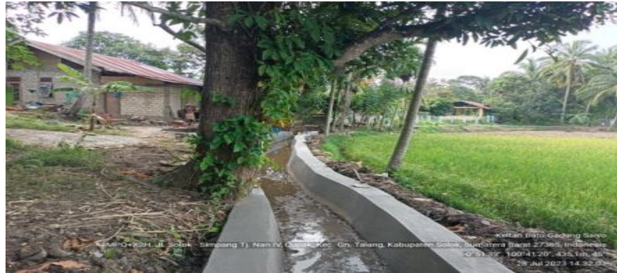
Gambar 4. Kegiatan rehabilitasi jaringan irigasi tersier Irigasi Irigasi Sawah Nyanta di Banda Putuih Jorong Koto Kaciak Nagari Muaro Paneh Kecamatan Bukit Sundi
