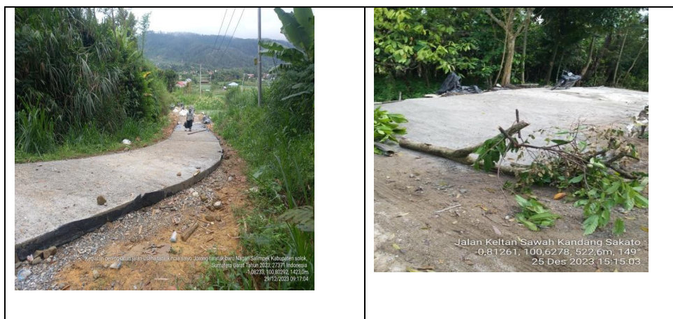
Gambar 14. Pembangunan jalan usaha tani di kec. Lembah Gumanti dan Kec. kubung
