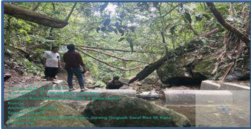
Pembangunan dam parit di Kec. IX Koto Sungai Lasi
