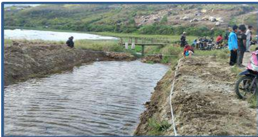
Rehab Embung Tabek Lanyak nagari Batu Bajanjang Kec. Lembang Jaya
