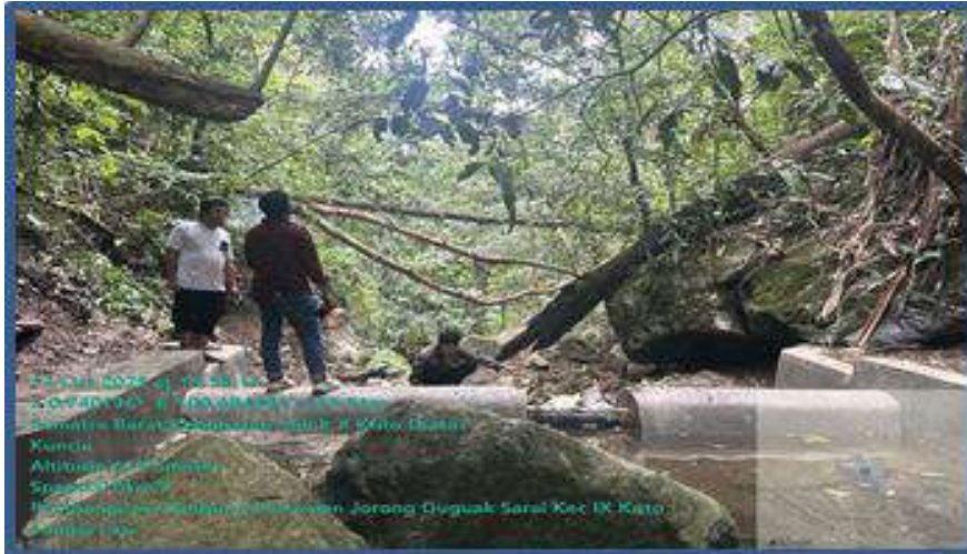
Pembangunan dam parit di Kec. IX Koto Sungai Lasi
