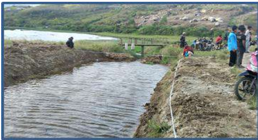
Rehab Embung Tabek Lanyak nagari Batu Bajaranjeng Kec. Lembang Jaya
